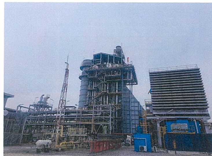
ภาพถ่าย HRSG BOILER
